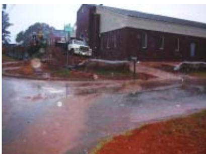
**ERODED SOIL WASHING INTO STORM DRAINS AND CREEKS.**
